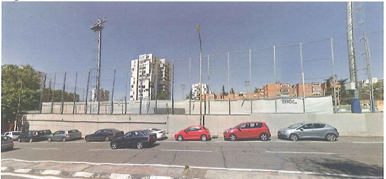
Muro de la instalación deportiva en Calle Silvano
